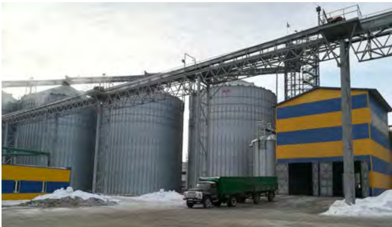
ЕЛЕВАТОР 40 000 ТОН КІРОВОГРАДСЬКА ОБЛ.
